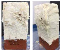
Très forte efflorescence apparente
