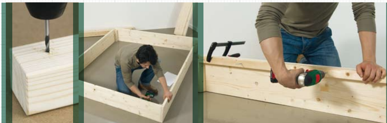
1. Assemblage des côtés du cadre et des montants à visser
