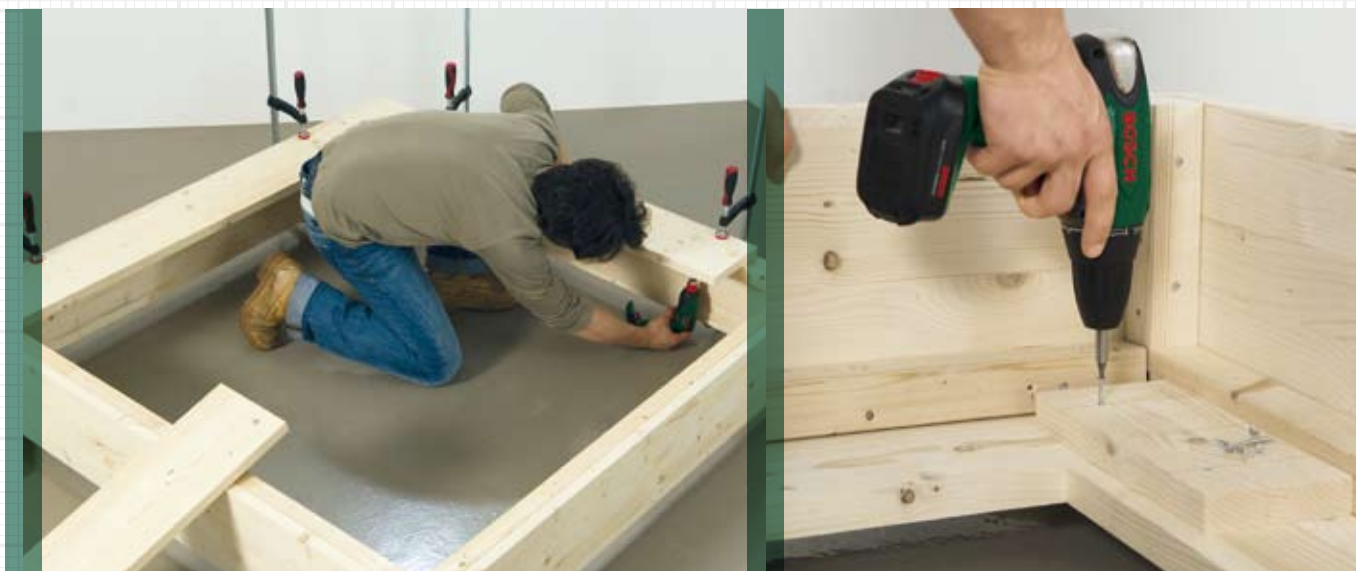
2. Assemblage des planches de siège et du cadre
