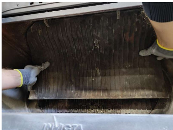
3 - Lever le déflecteur et le mettre en contact des pattes de maintien à l'avant de l'appareil
