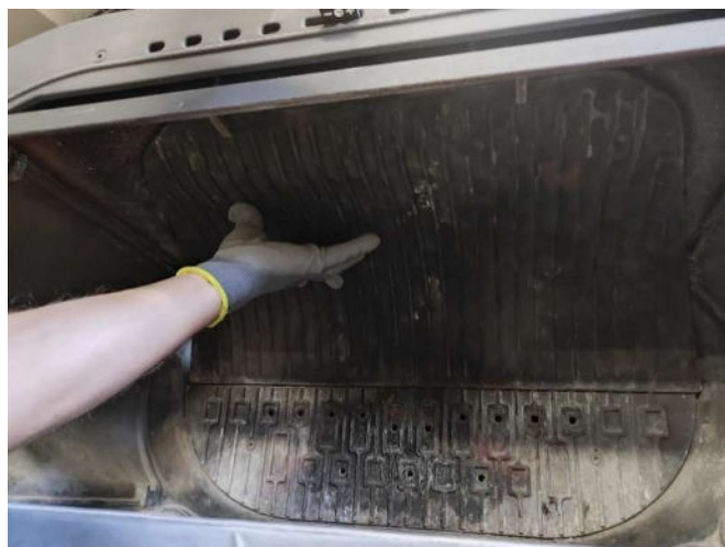
4 - Lever et insérer l'arrière du déflecteur derrière la taque
