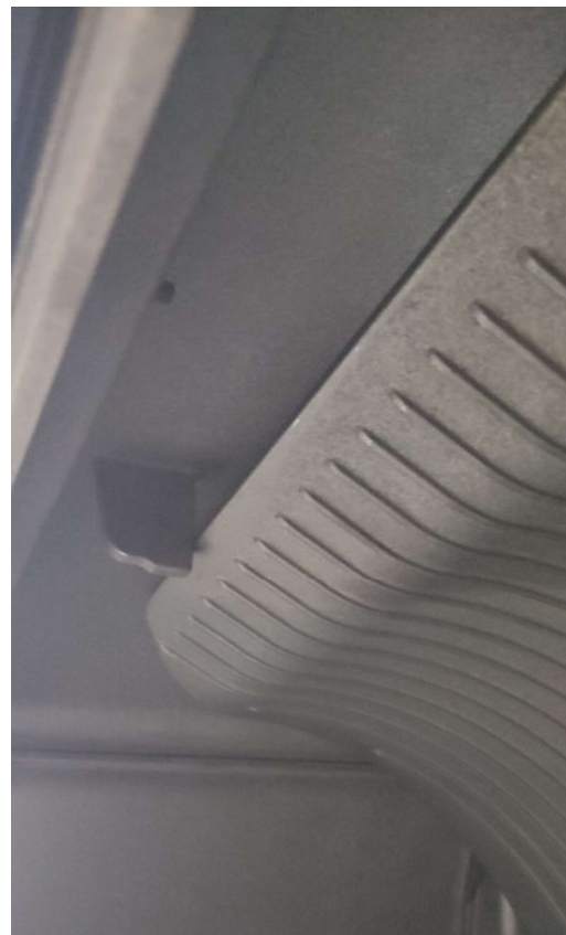
Défecteur en appui sur les pattes de maintien
