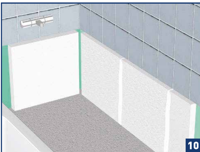
Posez la faïence en appui sur le béton cellulaire ou les supports. Dans le cas où la faïence est déjà posée, fixez les supports ou le béton cellulaire directement sur celle-ci.
