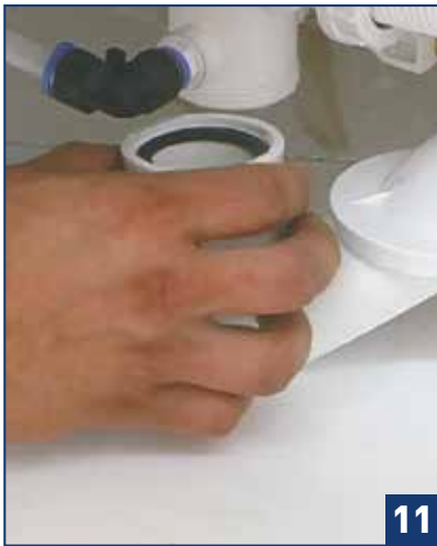
Raccordez le système de vidage à l'évacuation.
