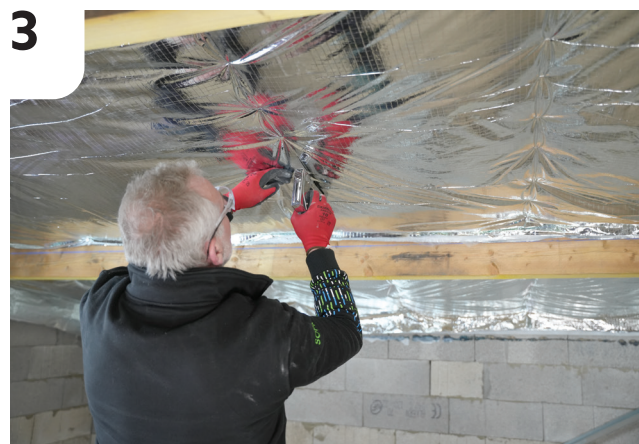
Pose d'un lé d'isolant mince. Fixations à l'agrafe.
