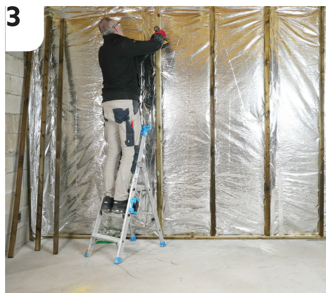
Installation de l'ossature bois secondaire.
