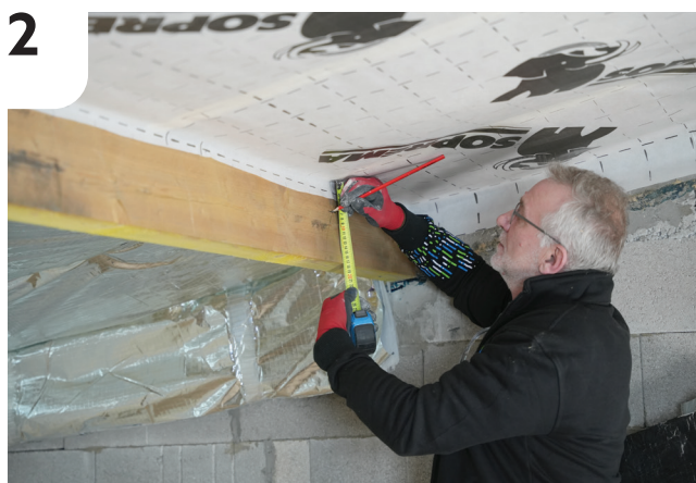
Traçage de l'emplacement des rails.
