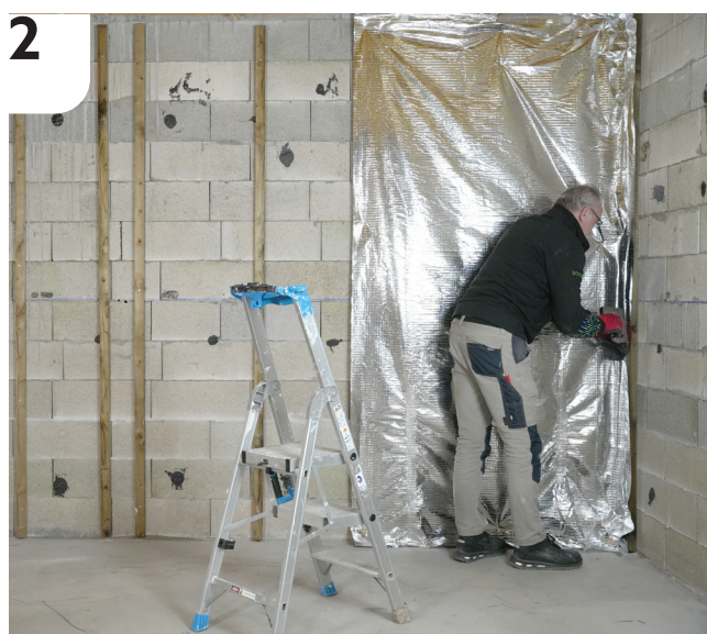
Pose verticale de l'isolant.
