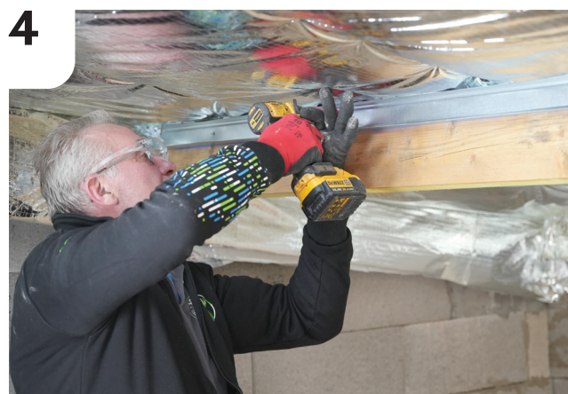
Pose de l'ossature métallique.
