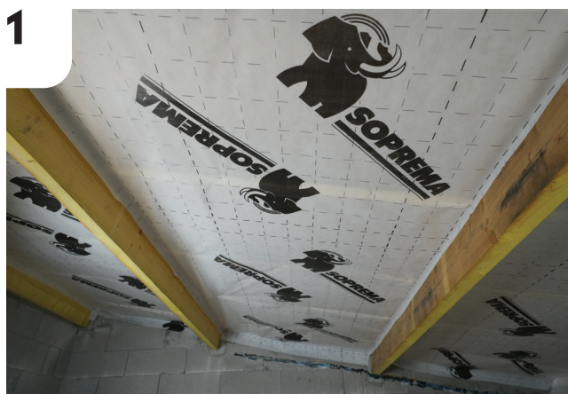
Préparation du support.
