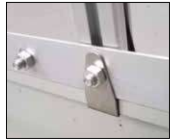
Crochet à positionner Haken anbringen Attach hook
