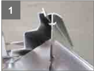
1 Pose de la lucarne sur faîtière par glissement. Anbringung des Fensters auf First durch Gleiten. Installing the window on roof ridge through sliding.
