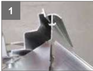
1 Pose de la lucarne sur faîtière par glissement. Anbringung des Fensters auf First durch Gleiten. Installing the window on roof ridge through sliding.
