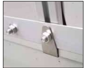
Crochet à positionner Haken anbringen Attach hook
