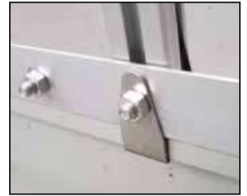
Crochet à positionner Haken anbringen Attach hook
