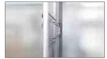
Clips de vitrage Gewächshausklammern Glazing clips
