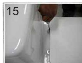
A l'aide d'un tournevis, serrez fermement les vis (fournies)
