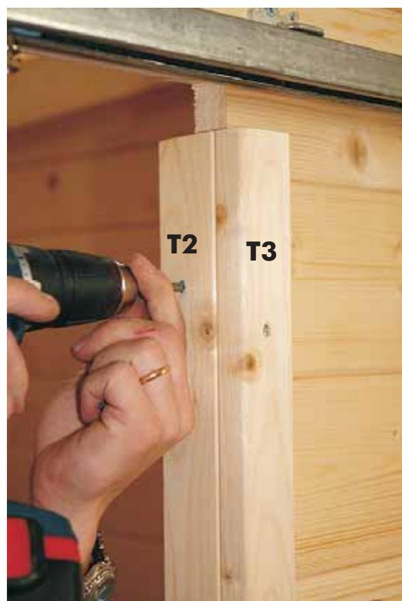
Fixez les profilés U T2 aux côtés de l'ouverture de la porte (vis 4x40mm, 4 pcs) et ensuite les barres verticales T3 aux profilés U de manière à ce que les bords supérieurs arrivent à ras bord (vis 4x40 mm, 4 pcs).
