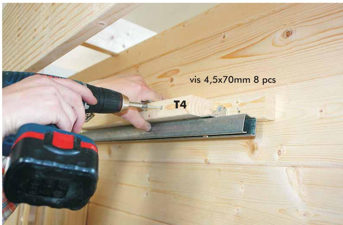
Fixez à la pièce T6 les pièces T4 au-dessus du rail coulissant en utilisant des vis 4.5x70mm.
