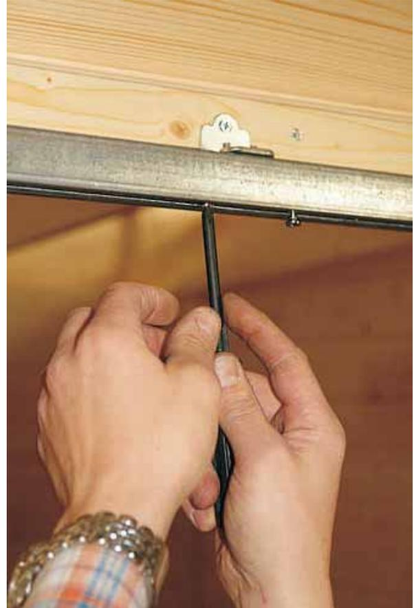
Réglez le fonctionnement des portes en vissant à la bonne position (à chaque bout et au milieu) les arrêts de porte de manière à ce que les portes s'ouvrent suffisamment.
