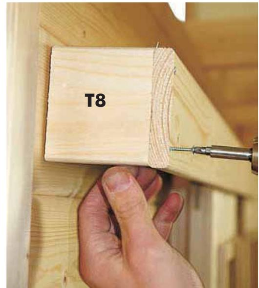
Fixez les baguettes de recouvrement T7 aux pièces T4 en utilisant des vis 3.5x35 mm et les baguettes T8 aux baguettes T7 (Remarque: baguettes pré-marquées!).
