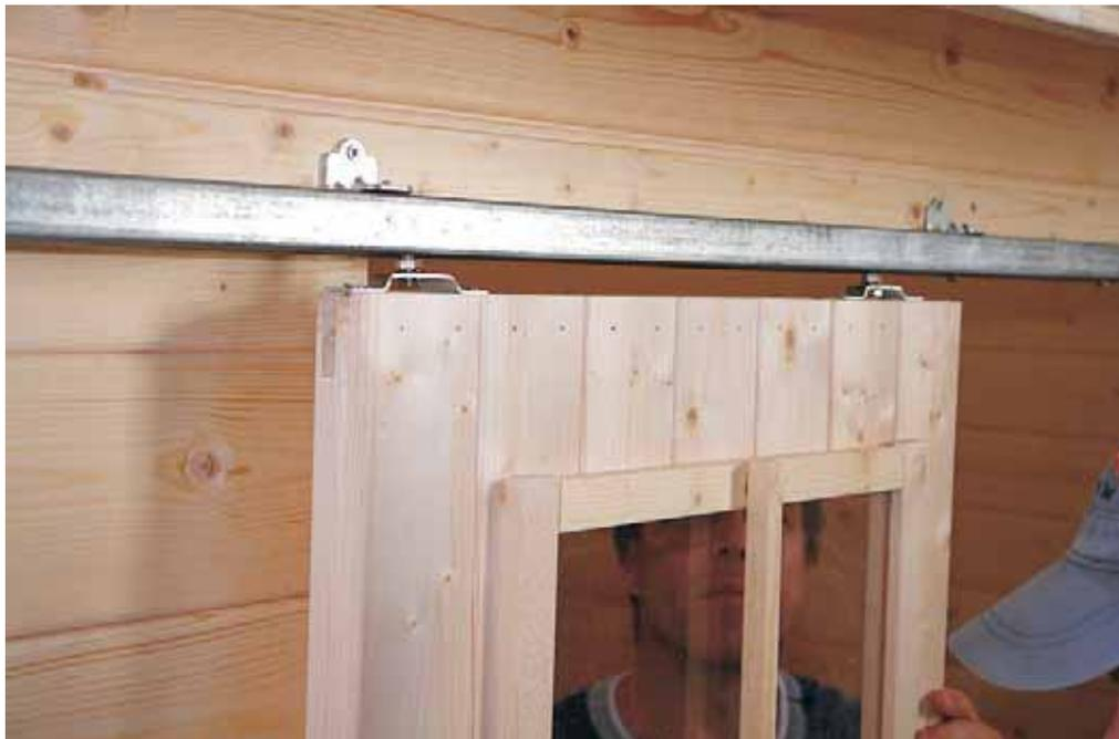
Vissez les ferrures de support des portes au bord supérieur des portes de manière à ce que les encoches pour le boulon regardent vers l'intérieur et soulevez les portes dans leur position.
