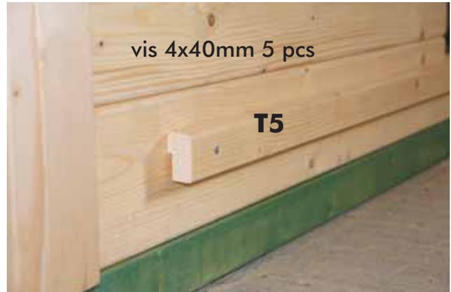
Fixez le seuil de la porte T5 avec des vis 4x40mm de manière à ce que la surface supérieure arrive au ras bord de la surface du bas de l'ouverture de la porte. Faites attention de ne pas visser pas depuis trop bas (voir le plan de détail ci-dessus).
