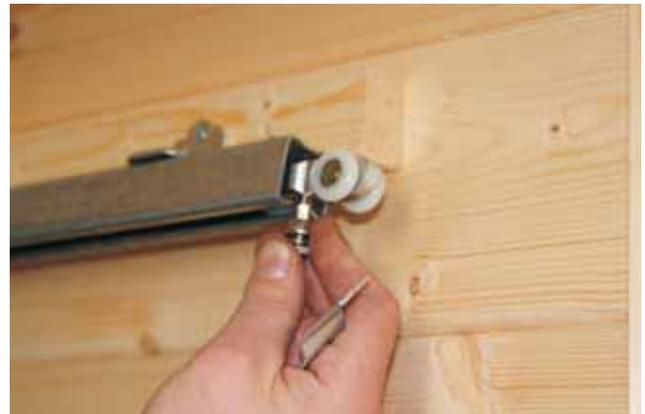
Ensuite fixez le rail coulissant à T6 en utilisant cinq vis 5x25mm de manière à ce que le bord supérieur du rail coulissant reste à la même hauteur que le bord inférieur de la barre de fixation T6. Installez les roues coulissantes au rail, deux de chaque côté.
