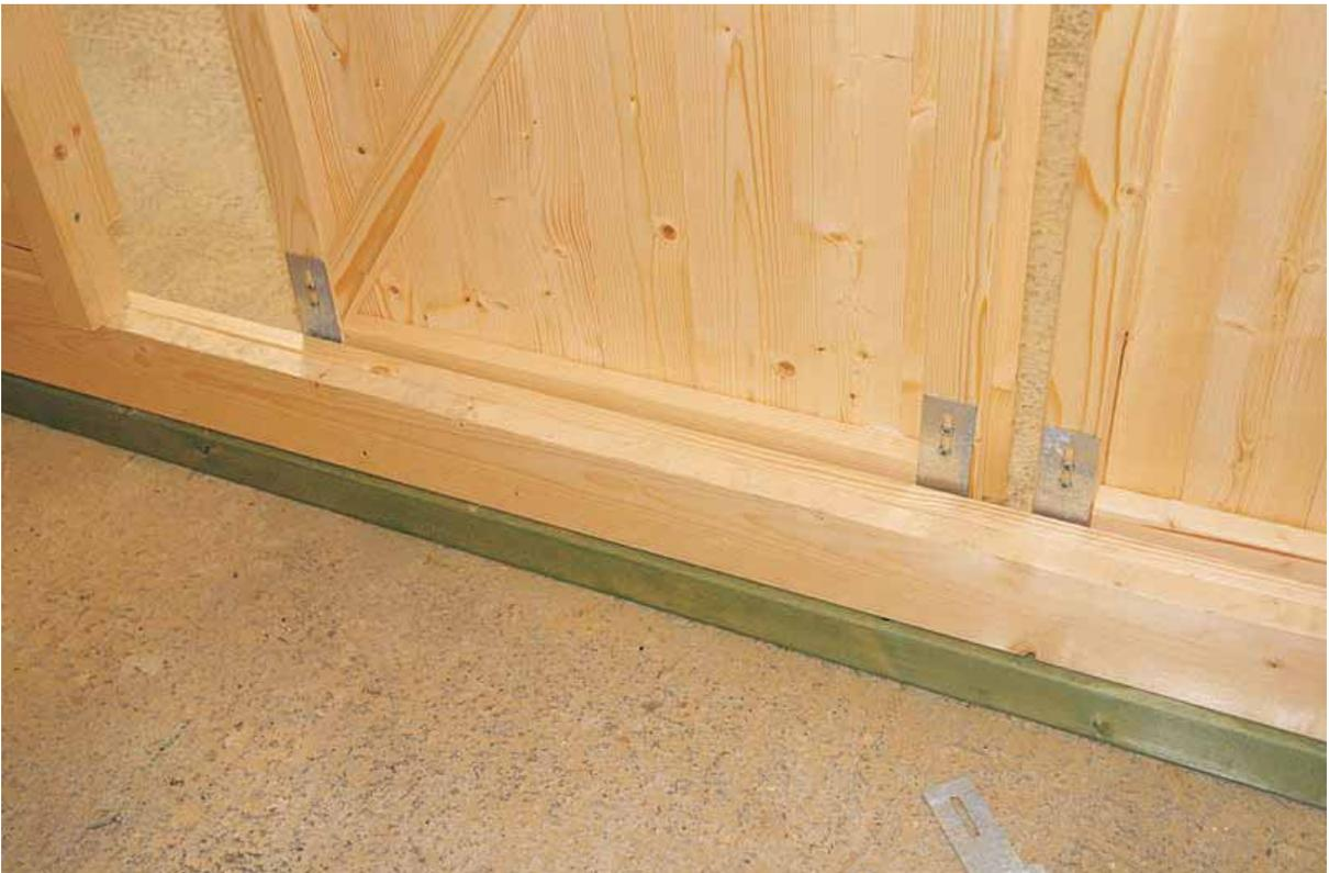
Fixez avec des vis (5x25mm, 8 pcs) les ferrures coulissantes des portes à la partie inférieure des portes.
