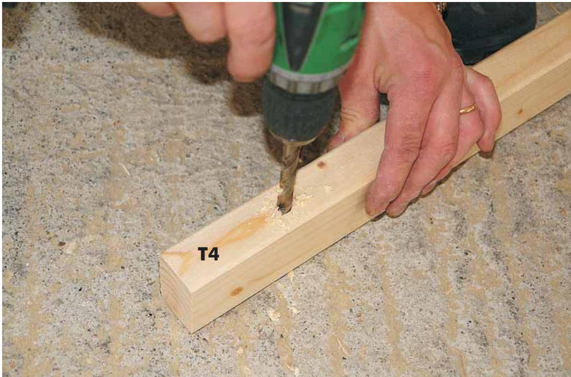
En utilisant une mèche de 10mm, percez des trous d'une profondeur d'env. 20mm dans les pièces T4 (trous à environ 10 cm du bout de la pièce).
