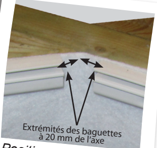
Extrémités des baguettes à 20 mm de l'axe Position de la baguette liner dans les angles.
