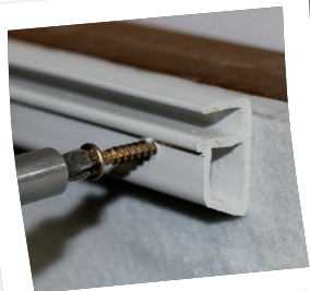
Fixation de la baguette de liner.
