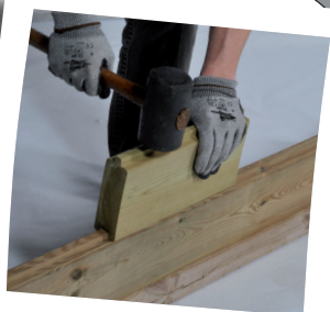
A l'aide d'un maillet, frappez sur la cale en bois pour emboîter à fond les madriers.
