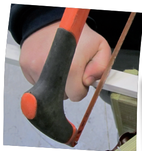
... et découpe de la baguette liner.
