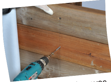
Fixez les consoles avec les vis de 6 x 90 (1 vis par madrier)
