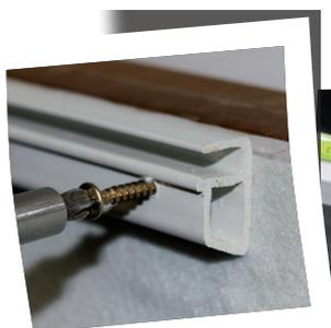
Fixation de la baguette de liner.
