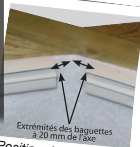
Extrémités des baguettes à 20 mm de l'axe
