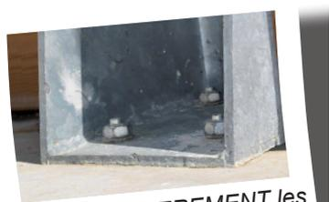
Enfoncez **ENTIEREMENT** les gougeons d'ancrage (seule la tête doit rester visible).
