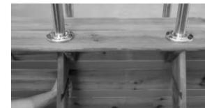
5 : Installer les marches côté anti-dérapant vers le haut et fixer l'ensemble avec les vis 60x5mm fournies.
