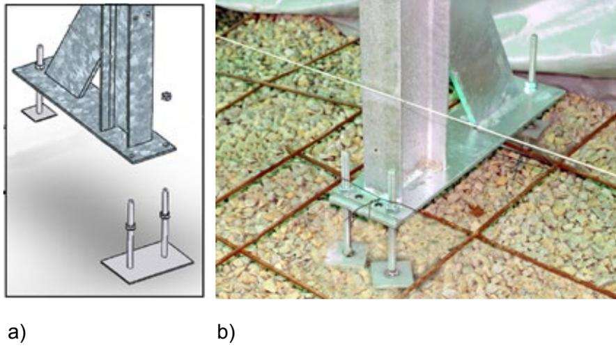
Figure 3 – a et b - Mise en place des vérins sur les jambes de force
