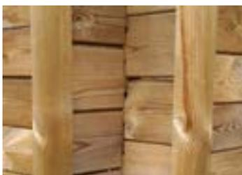
Monter un profil de finition à chacune des extrémités des parois. Pour ce faire, utiliser 3 pointes à tête bombée de 2.8 x 60 : une en haut, une au milieu et une en bas de chaque extrémité. Faire en sorte que les pointes soient au centre des lames de paroi pour éviter leur éclatement.
