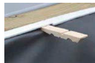
Figure 22 – Verrouillage du liner grâce à des demi épingles à linge
