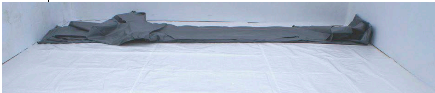
Figure 21 – Dépliage du liner
