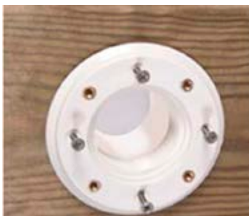
Figure 15 – Montage des traversées de paroi
