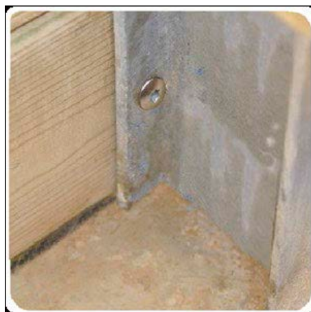
Figure 8 – Verrouillage des lames sur les jambes de force
