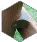
Plateforme sécurisée : garde-corps et cales anticoincement.
