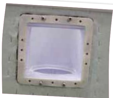
Fixation du 1 er joint de skimmer.
