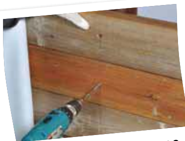
Fixez les consoles avec les vis de 6 x 90 (1 vis par madrier)
