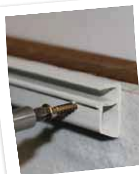
Fixation de la baguette de liner.
