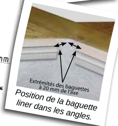
Fixation de la baguette de liner.
