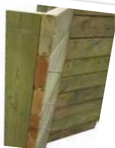
Assemblez le renfort en mettant une vis par madrier.
