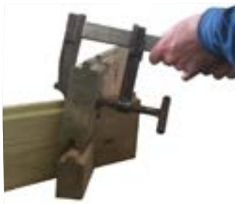
Loose board • Tabla suelta • Madrier voilé • Loses Brett • Tavola libera • Losse plank • Tábuas solta
