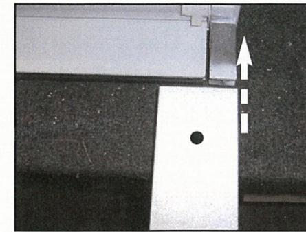
Présenter la coulisse devant le coffre et l'engager dans la queue de joue jusqu'à buter contre le coffre. La coulisse doit être enfoncée au maximum.
