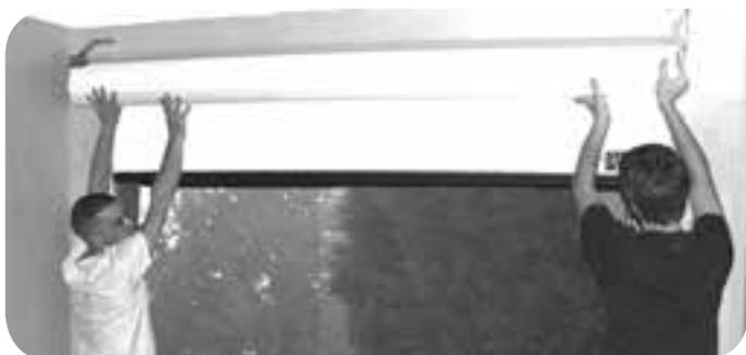
Une fois le tablier assemblé et enroulé, enfiler le dans les coulisses en commençant par la barre palpeuse. Faire attention au sens des lames.
