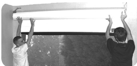
Une fois le tablier assemblé et enroulé, enfilez le dans les coulisses en commençant par la barre palpeuse. Faire attention au sens des lames.
