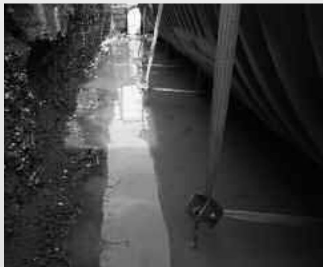
Cuve 35 m³ avec sangles CMU (Charge Maximale Utile) 5 tonnes, largeur 50 mm, ancrées avec le kit Plantco (1 ensemble de base EB PLANTCO + 6 ensembles complémentaire EC PLANTCO)
