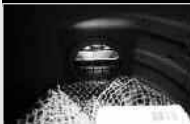
1 - Dévisser le tampon Ø 400 mm côté Sortie
