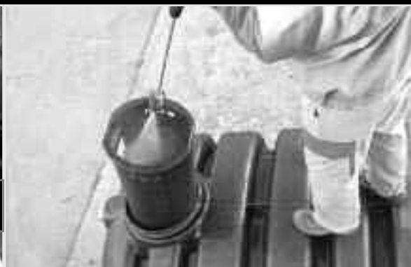
5 - Bloquer le préfiltre en calant le fond en biais sur le manchon de sortie. - Laver au jet haute pression le filet. - Préfiltre permettant l'écoulement des eaux de lavage dans l'appareil.
