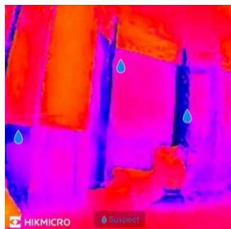
Figure 3-2 Reconnaissance des anomalies de fuite d'eau
