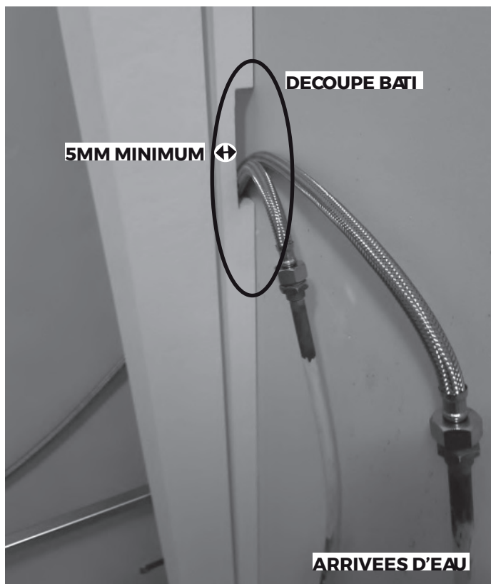
Découpe réalisée avec un disque diamant
