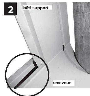
Faire la même remontée de mastic sur la partie basse du châssis bâti support, entre les deux tubes coulissants
