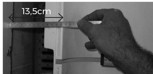
• Les plinthes servent de gabarit de pose. Présenter une plinthe sous le receveur garantit la hauteur minimum à respecter (soit environ 8cm).
