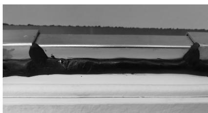
3. faire le complément du mastic comme sur la photo ci-joint (appui entre la résine et le joint mousse blanc)
