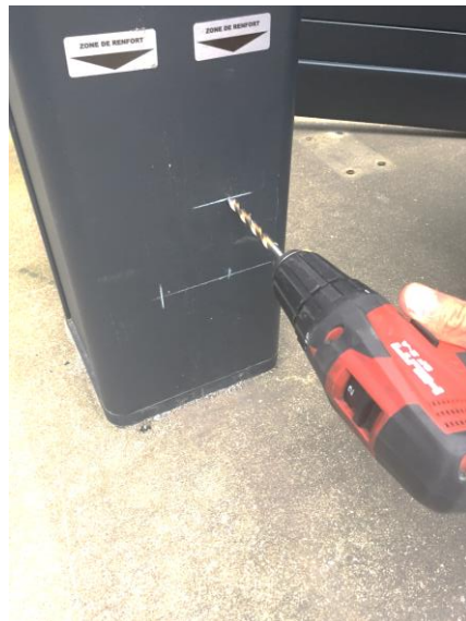
Perçage Ø 6,5mm
