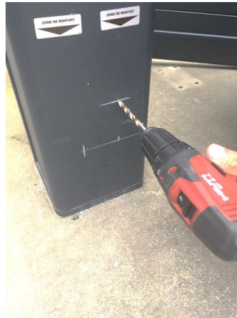
Perçage Ø 6,5mm
