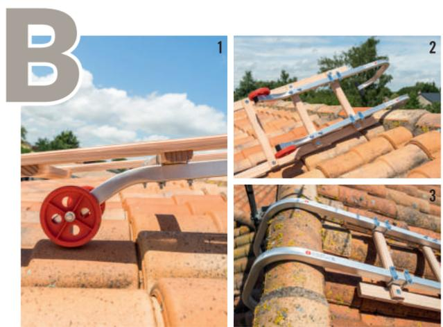
**B** Installer l'échelle sur le toit
