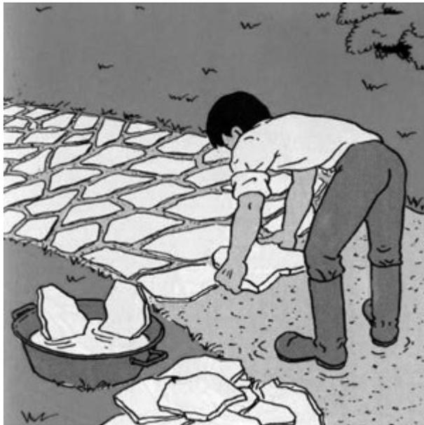
Mouillez les dallages et disposez-les sur le mortier frais.
