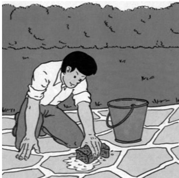
Les pierres tachées de ciment doivent être rapidement nettoyées avant que le ciment ait le temps de sécher.
