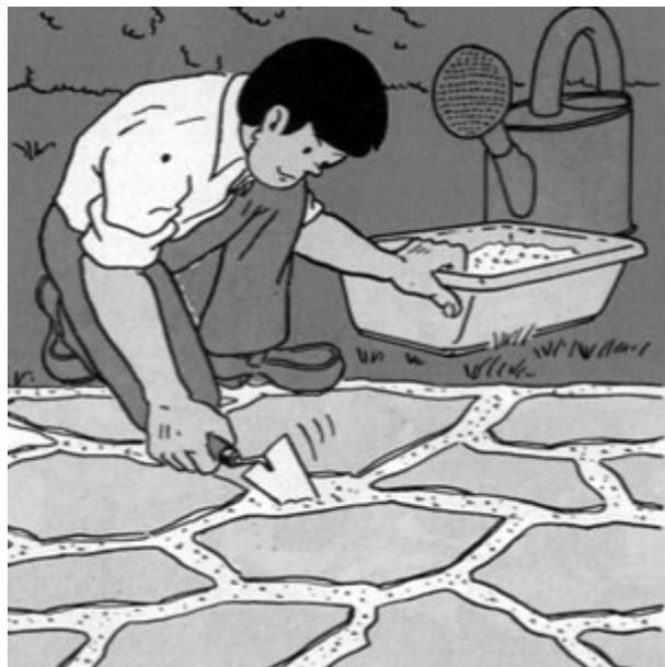
Pour les dallages en pierre, mouillez les joints, bourrez les avec du mortier, puis lissez les soigneusement avec une truelle.
