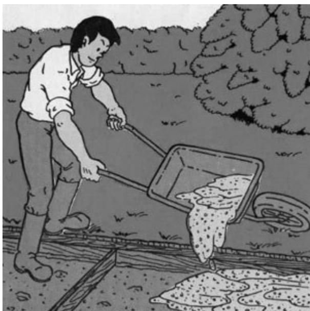
Versez le béton dans la tranchée et le répartir jusqu'au niveau défini par les chevrons latéraux de guidage.
