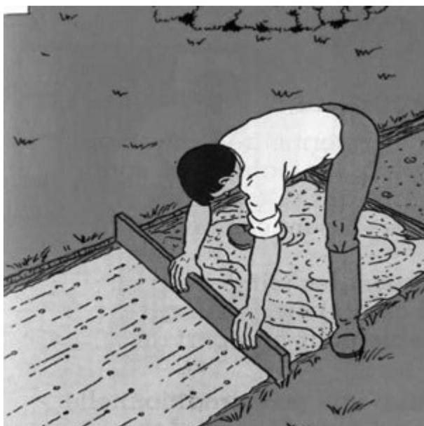
Égalisez le béton à l'aide d'une règle appuyée sur les chevrons de guidage.
