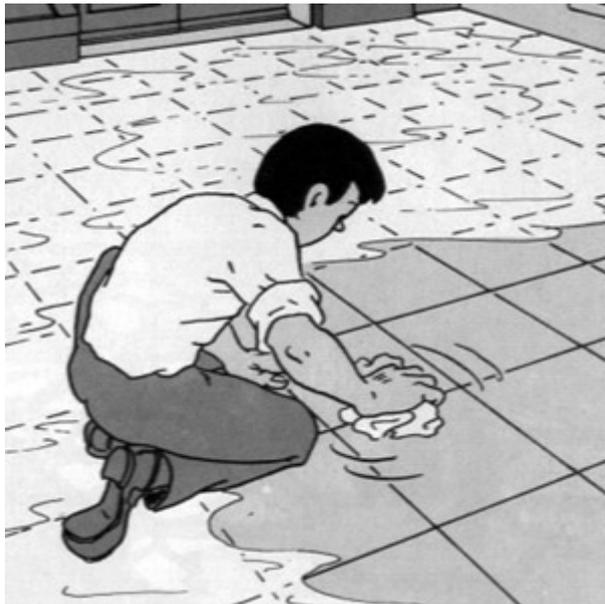
Puis nettoyez le carrelage par petite surface et lissez les joints à l'aide d'un chiffon roulé en boule.
