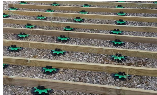
Pose sur plots (lambourde bois impératif)
