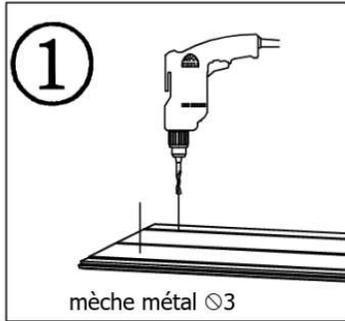
Positionner les lames de toit sur les pannes alu puis pré-percer l'ensemble dans les rainures avant de les fixer
