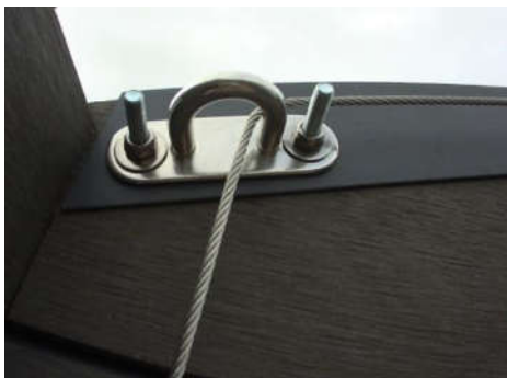
Cadène : à fixer sur renfort alu lame du haut
