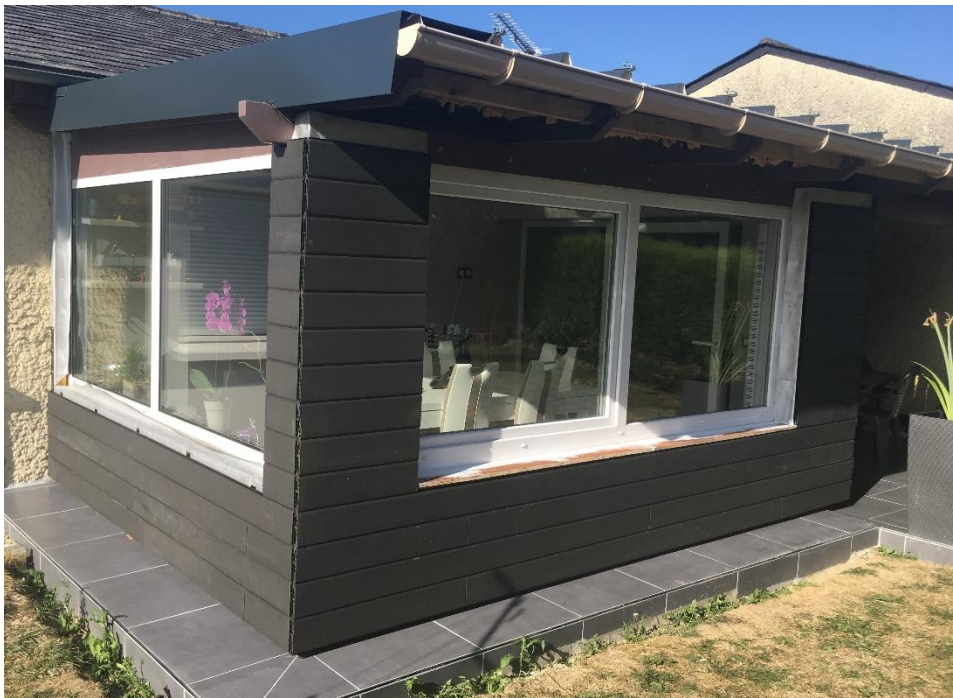
Après rénovation avec lame de bardage composite Anthracite (reste quelques finitions)
