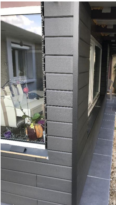
Après rénovation avec lame de bardage composite Anthracite (reste quelques finitions)
