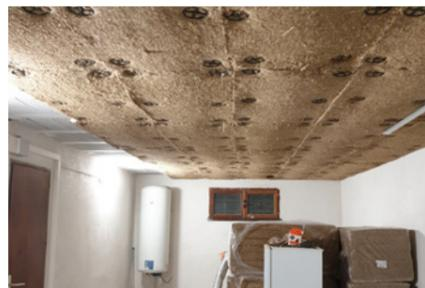
Pose sous plancher maçonné, fixation par chevilles iso
