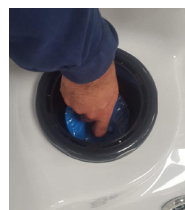
Dévissez le filtre et le retirez
