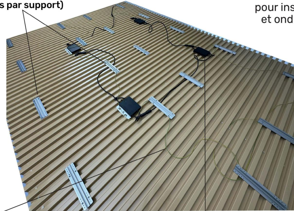
2- Installer les cables de mise à la terre suivant le plan fourni (avec une autre vis)
