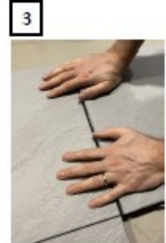
3 Exercer une pression manuelle sur les dalles ou lames pour effectuer le clippage
