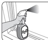
**4 Préparer la fenêtre.** Dans le vaporisateur, ajoutez quelques gouttes de liquide vaisselle dans de l'eau froide. Vaporisez généreusement ce mélange sur la vitre (côté intérieur). Le film anti-chaueur sera plus facile à positionner en utilisant ce mélange abondamment. Conseil : l'utilisation d'eau est essentielle pour l'adhésion du film !
