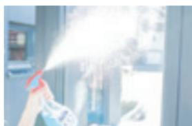
3. Vaporiser généreusement la surface vitrée avec la solution d'application **d-c-fix®** (ou à défaut un mélange d'eau et de 2 gouttes de produit vaisselle).
