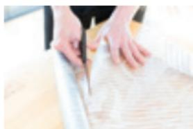
2. Marquer les dimensions souhaitées au dos du film en respectant une distance de 2mm par rapport au cadre de la fenêtre, puis découper le film **d-c-fix®**.
