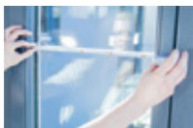
1. Le film doit être posé sur une surface vitrée plane et soigneusement nettoyée. Utiliser un détergent habituel ou bien la solution d'application **d-c-fix®**.
