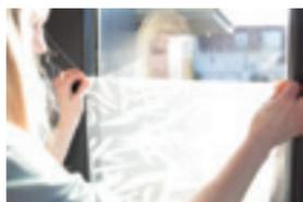
5. Placer le film sur la vitre. Le film glisse et se positionne facilement sur la surface vitrée humide.
