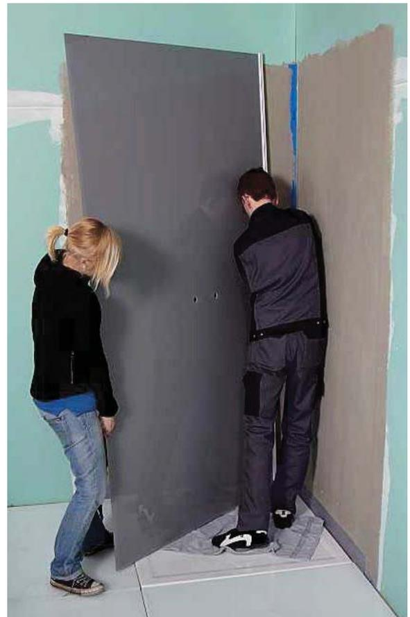
**3.16** D'abord enlevez le film de protection et en commençant par le coin, placez les panneaux design sur les murs.
