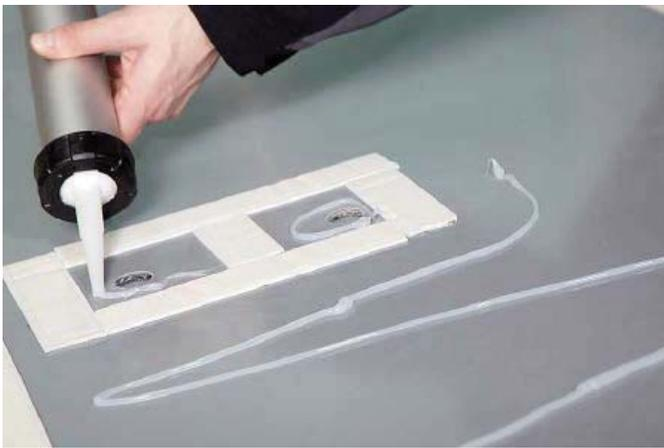
**3.14** Puis étalez le silicone neutre pour pierre naturelle sans acide acétique (fournis dans le kit de montage) de façon ondulée (en forme de vagues). Siliconez également les trous et décrochements, comme montré sur l'image ci-dessus.
