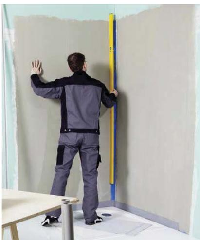
**1.1** Vérifiez que les murs soient d'aplomb. La base doit être solide, résistante, sèche et très propre (pas de poussière, graisse ou saleté).
