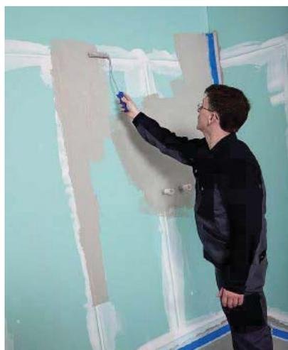
**1.2** Vérifiez que les murs soient imperméabilisés (hydrofugés). L'application d'un enduit hydrofuge de protection préalable est possible.
