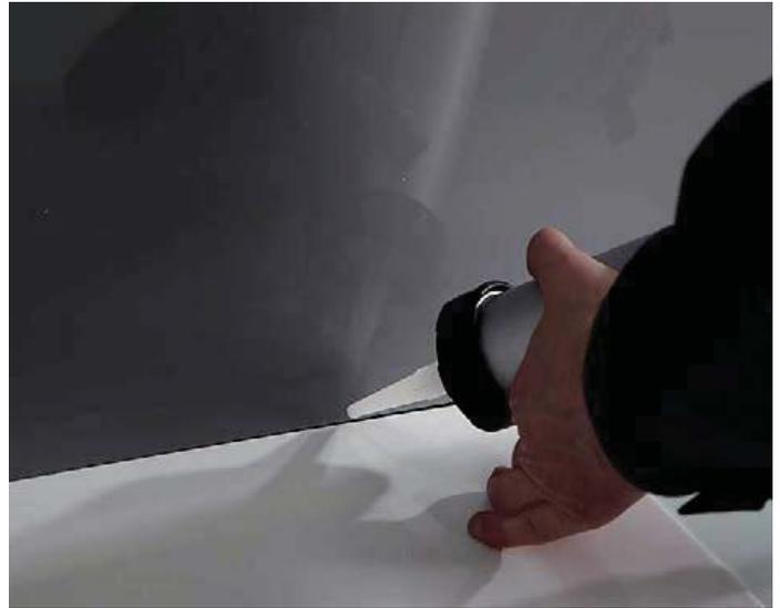
**3.22** Siliconez horizontalement les panneaux en bas avec silicone neutre pour pierre naturelle sans acide acétique. Laissez le silicone sécher pendant 24 heures.
