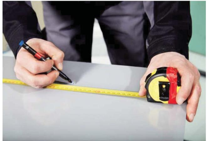
**2.3** Maintenant marquez les mesures de coupe avec un marqueur sur la face avant du panneau design (l'arrière est marqué avec des autocollants). Ne retirez pas le film de protection.
