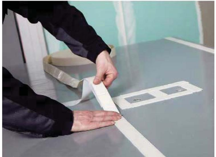
**3.8** Prenez du ruban adhésif double face (largeur 40mm, épaisseur 2mm, disponible dans le kit de montage) et appliquez-le à 20mm du bord du panneau. Veuillez renforcer les grands perçages et les décrochements (pour toilettes, lavabo, etc.) avec du ruban adhésif. Disposez les rubans adhésifs à 40cm les uns des autres.
