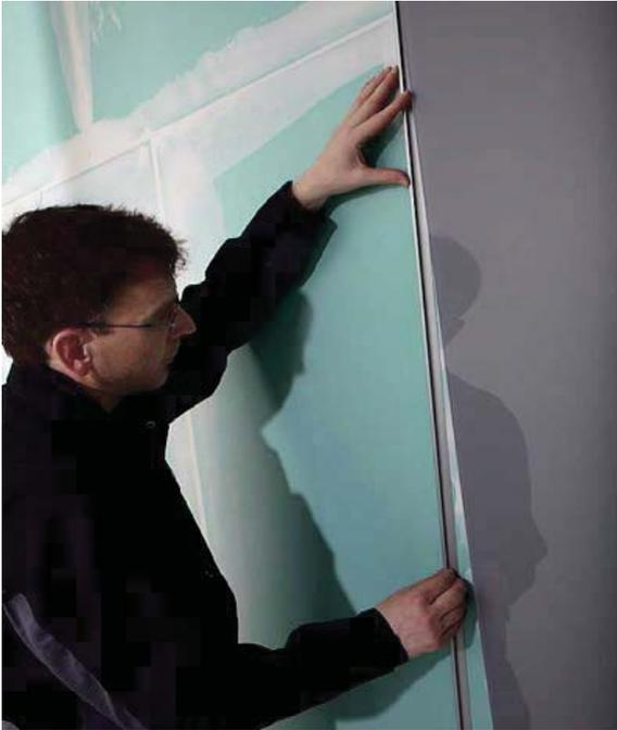
**3.17** Le profilé final (également avec une ligne fine de silicone sur un côté) peut être ajouté avant ou après la pose du panneau.
