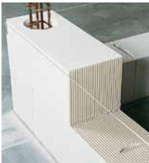
■ Poser les blocs suivants sur un lit de mortier-colle PREOCOL / YTONG FIX.
