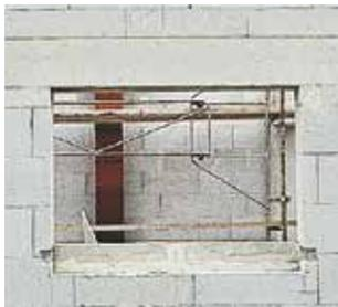
■ Poser ou couler les appuis de fenêtre conformes au NF DTU 20.1 sur l'allège brute.
