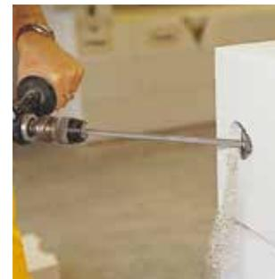
■ Percer à 45° les trous de scellement à l'aide d'une mèche spéciale d'un diamètre de 60mm sur une profondeur de 15 cm. Bien dépoussiérer les trous.
