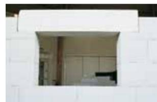
Dans tous les cas, la pose du linteau préfabriqué ne doit pas gêner la mise en oeuvre du chaînage horizontal périphérique.:
