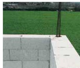
Mettre en œuvre les blocs par croisement pour superposer les réservations. Celles-ci sont armées puis remplies de béton.
