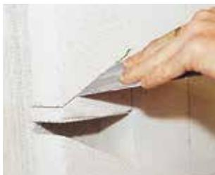
■ Après la pose des menuiseries, dépoussiérer, humidifier puis reboucher les scellements au plâtre fort (uniquement pour les scellements intérieurs).
