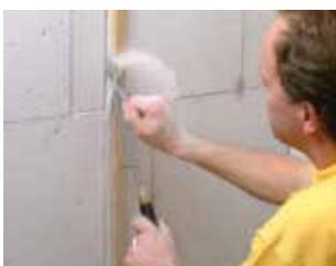
■ Percer avec une mèche adaptée, la cavité recevant le boîtier électrique. Reboucher les saignées avec du plâtre fort.
