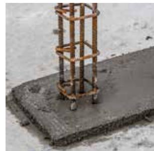
Les armatures des chaînages verticaux partent des fondations et montent jusqu'au sommet de l'ouvrage de manière continue.
