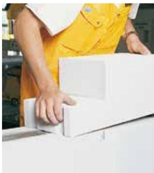
■ Ajuster les jambages en sciant les parties de blocs qui dépassent, aux cotes brutes de la maçonnerie (voir illustration de l'appareillage ci-contre).
