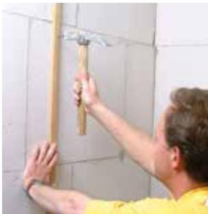
■ Creuser la saignée avec la gouge à main, en s'appuyant sur la baguette "guide", ou utiliser une rainureuse électrique.
