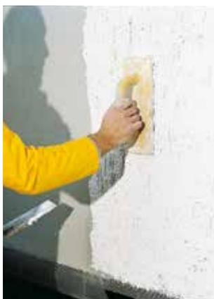
■ **Enduit multicouche**, (conforme au NF DTU 26.1) obligatoirement réalisé en 3 couches, avec un délai de séchage de plus de 3 jours entre chaque couche :
