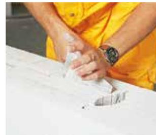
■ Déposer un lit de mortier avec des granulats de faible granulométrie (max 15mm) au fond de la gorge et déposer un acier HA 8
