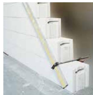
■ Découper simplement à la scie égoïne ou à la tronçonneuse les parties de bloc en trop, en s'appuyant sur les guides.
