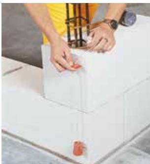
■ Encoller sa face verticale (départ d'angle: p.11) avant la pose du 2ème bloc. Fixer le cordeau d'alignement.
