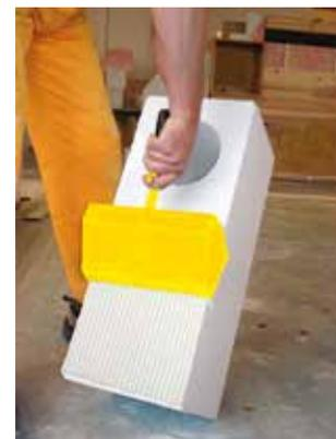
■ Utiliser une truelle wave YTONG adaptée à la largeur des blocs. Tirer le mortier-colle en appuyant sur la truelle.
