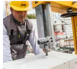
■ Veillez à encoller les faces verticales lisses des blocs ajustés ou en rupture d'encastrement.
