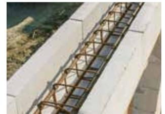
■ Remplir avec du béton. Veillez à bien respecter un enrobage de béton de 10mm autour des armatures. Le béton utilisé dans les chaînages doit avoir les caractéristiques suivantes :
