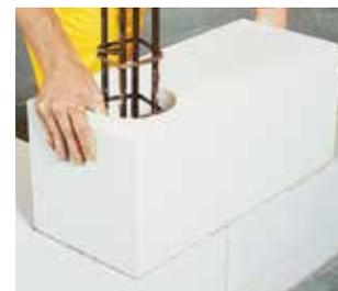
Suivre le même procédé pour les angles d'encadrement des baies et des fenêtres en zone sismique
