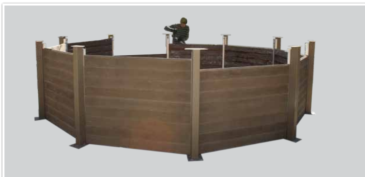
Mise en place de la traverse n° 2 jusqu'à la 9ème rangée.
