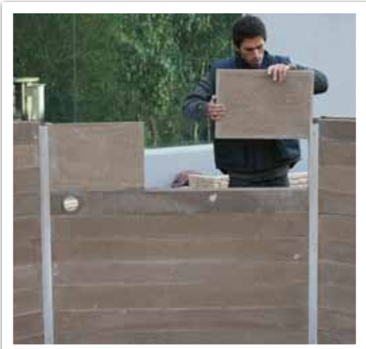
Mise en place de la traverse n° 5.
