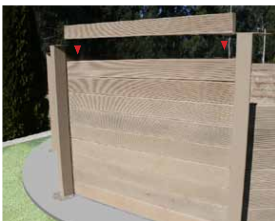
Emplacement des traverses n°3.
