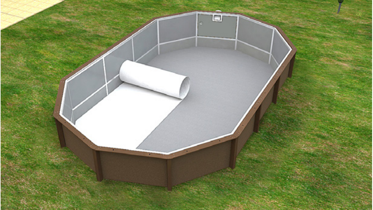
Emplacement du feutre Géotextil
