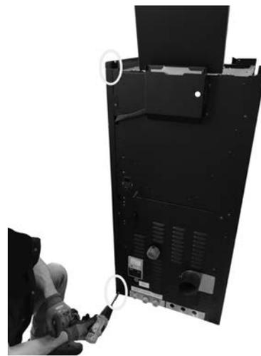
Fig. 62 - Fixation arrière du panneau latéral
