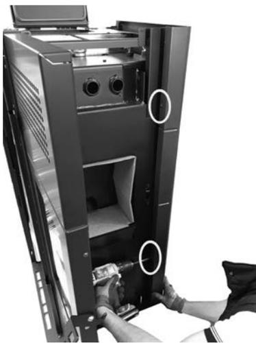
Fig. 61 - Fixation avant du panneau latéral
