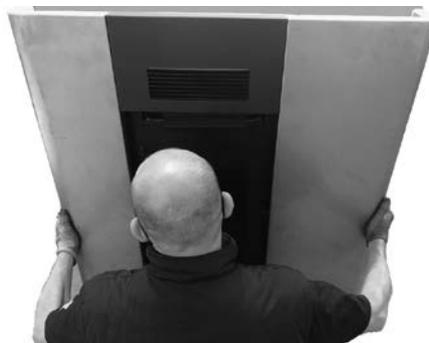
Fig. 48 - Positionnement du cadre
