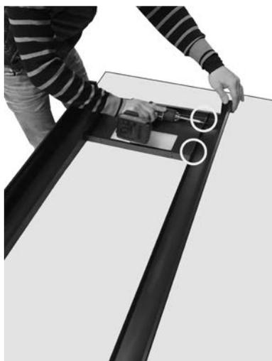
Fig. 24 - Fixation de montant
