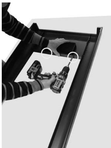
Fig. 25 - Fixation de la grille
