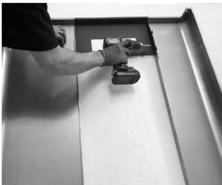
Fig. 44 - Fixation de montant
