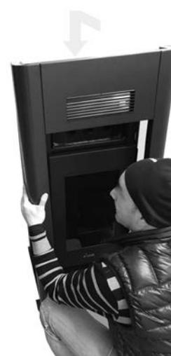
Fig. 26 - Positionnement du cadre
