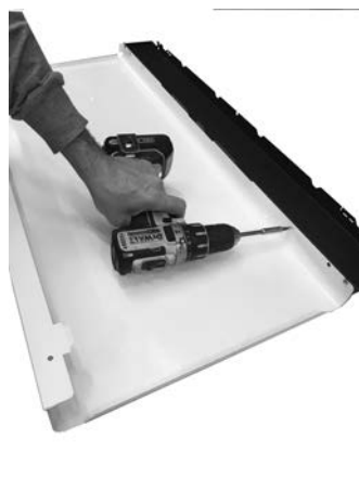
Fig. 45 - Fixer le flanc coloré
