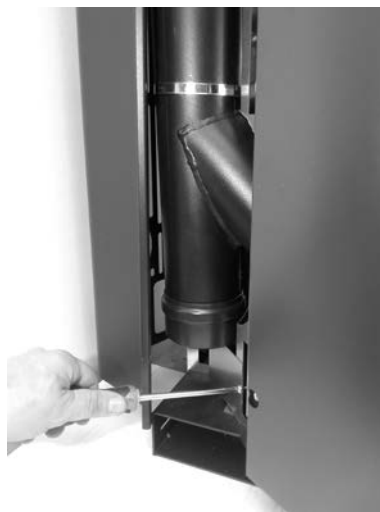
Fig. 66 - Dévisser le dispositif de blocage du bouchon
