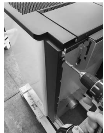
Fig. 46 - Fixer le flanc complet
