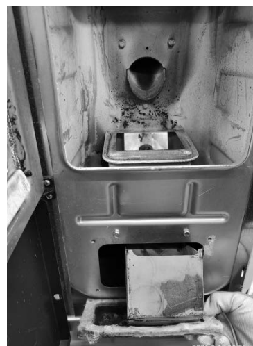
Fig. 69 - Retirer le bouchon d'inspection
