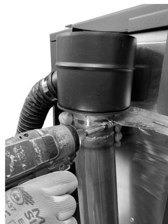
**Fig. 57 - Bloquer avec un collier de serrage**
