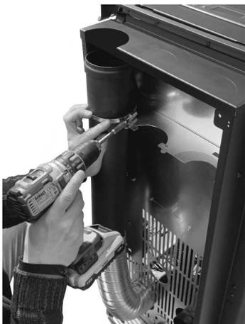
*Fig. 72 - Fixer le tuyau d.80 mm*
