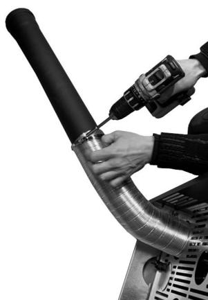
*Fig. 70 - Raccorder le tuyau d.80 mm*
