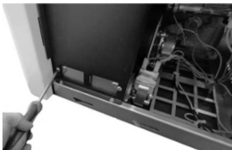
Fig. 87 - Nettoyage de le ventilateur ambiant (Atena<sup>3</sup> Plus 12/14 - Duke 12/14 At - Saba 12/14)
