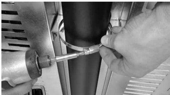
**Fig. 66 - Bloquer avec un collier de serrage**
