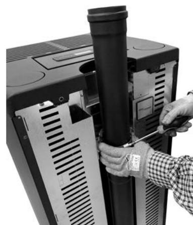
Fig. 62 - Conduit arrière d'évacuation des fumées monté
