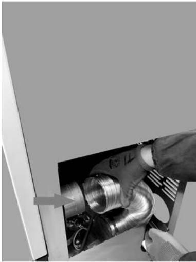
**Fig. 87 - Détacher le tuyau flexible**
