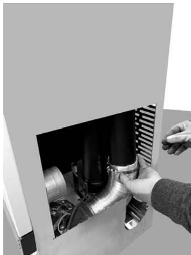
**Fig. 91 - Raccorder les tuyaux**
