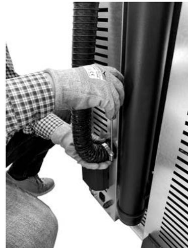
**Fig. 65 - Raccorder le tuyau de l'air comburant**
