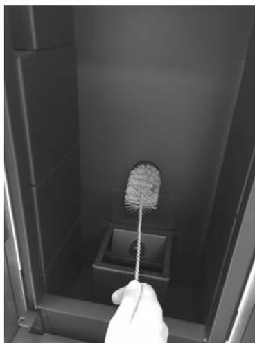
Fig. 30 - Nettoyage avec nettoie-pipes
